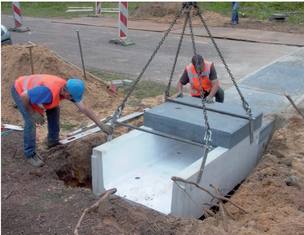
Foto 4: Het plaatsen van het laatste tunnelelement (Foto Marcel van der Voort). Photo 4: The placement of the last tunnel piece (Photo Marcel van der Voort).
