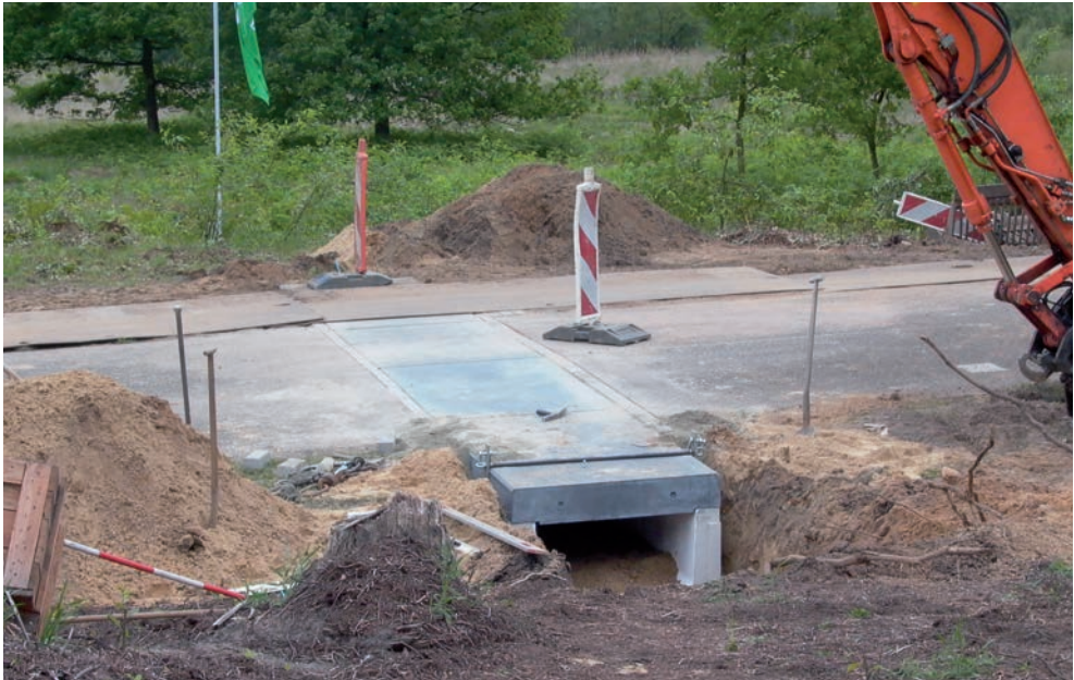
Foto 1: De situatie, voordat het laatste tunnelelement was geplaatst (Foto Marcel van der Voort). Photo 1: Situation before the last tunnel piece was put in place (Photo Marcel van der Voort).
